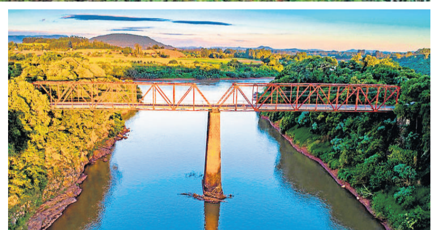
Ou a arquitetura da ponte de ferro, em Arroio do Meio
