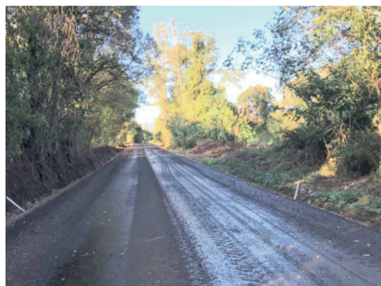
Obras na Ernesto Alves em fase final
