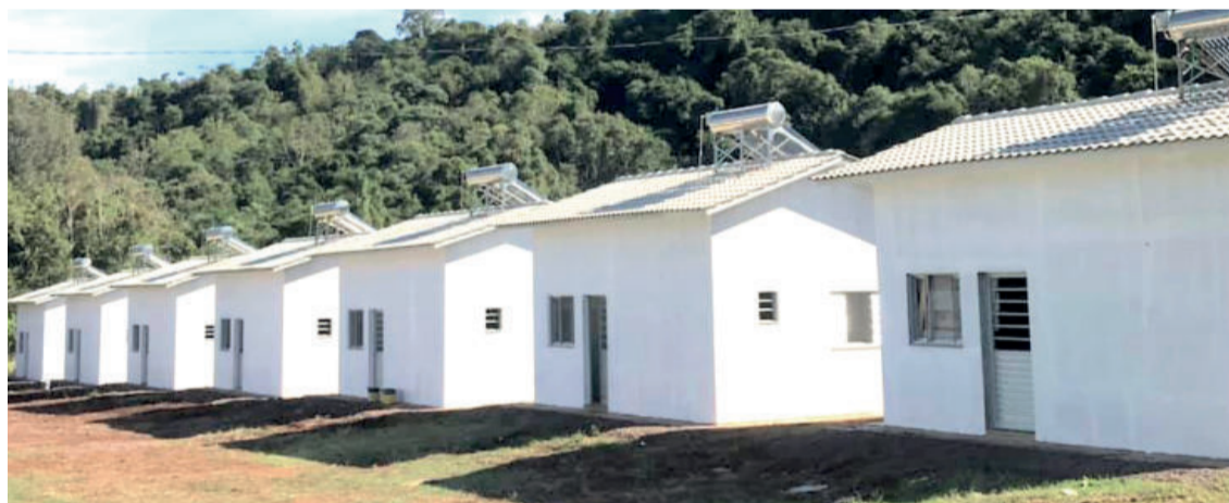
50 moradias também estão em estágio final de obras
