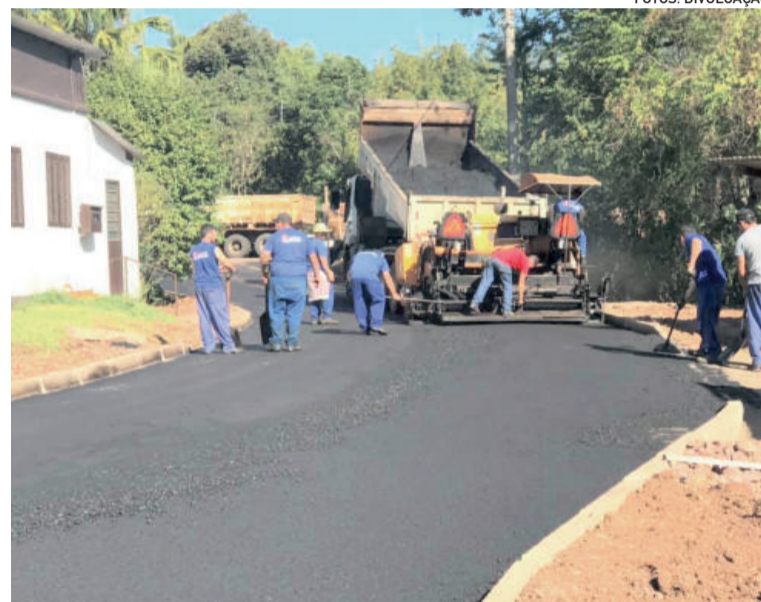
Rua do Moinho recebeu asfalto
