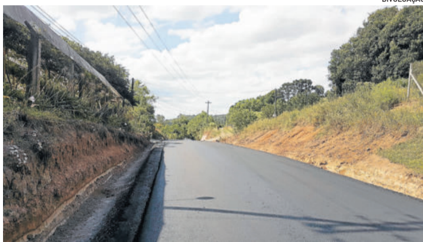
Pavimentação da estrada de São Roque à RSC-453
