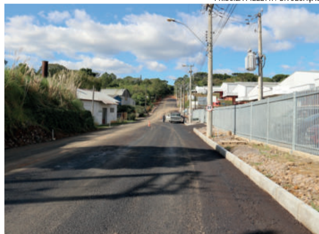
Obras para pavimentação da rua Olindo Antônio Bortolini
