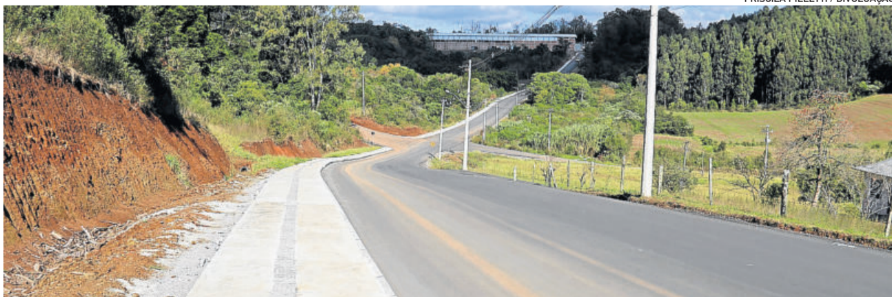
Pavimentação da Perimetral Oeste
