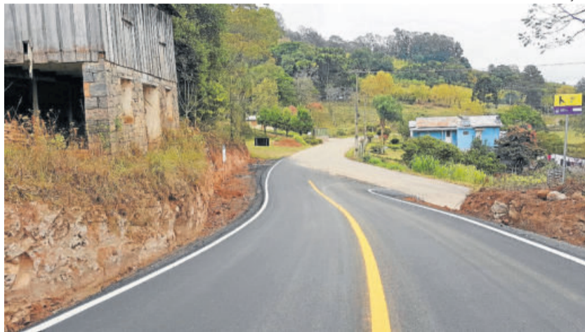
Pavimentação Linha Baú ao Borghetto
