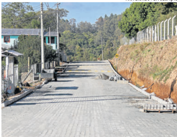
Pavimentação da rua Vicentino Maziero
