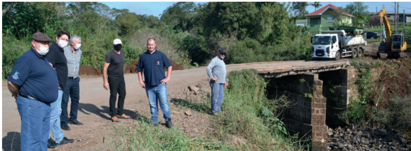
Prefeitos dos dois municípios acompanharam o início da obra
