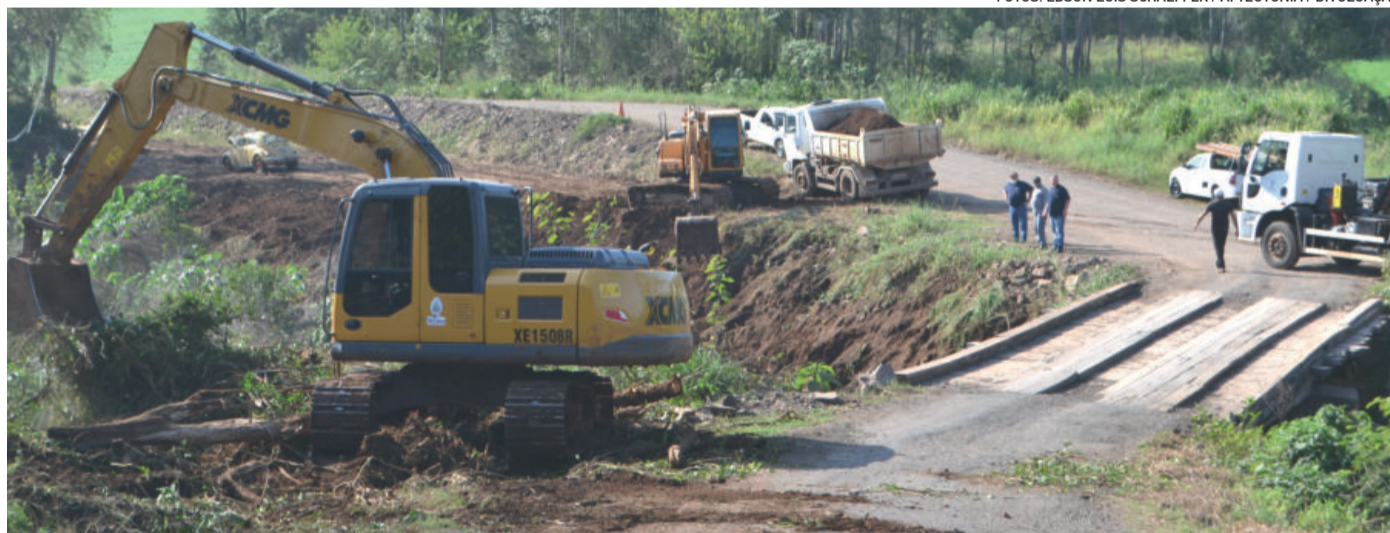
Secretarias de Obras dos dois municípios iniciaram a obra nesta segunda-feira
