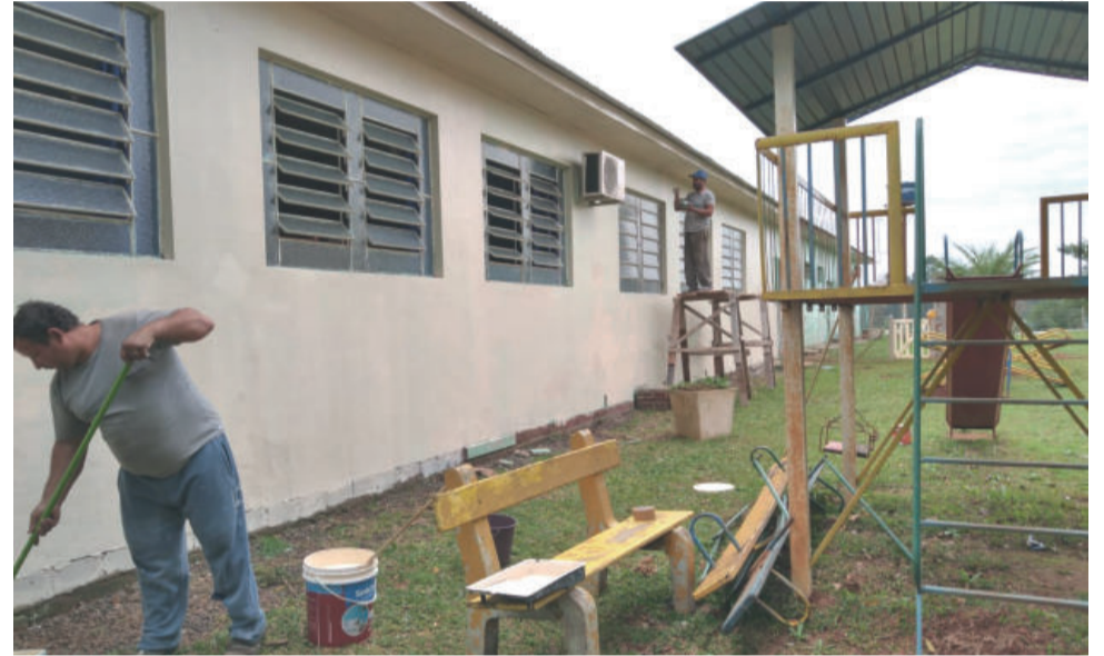
EMEI Fazendinha ganhou nova pintura nas paredes
