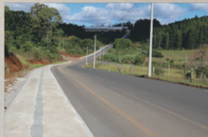
AVENIDA PERIMETRAL OESTE
