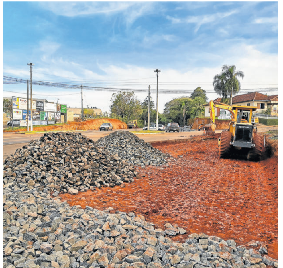
Obras da rótula do Bairro Languiru estão em ritmo acelerado
