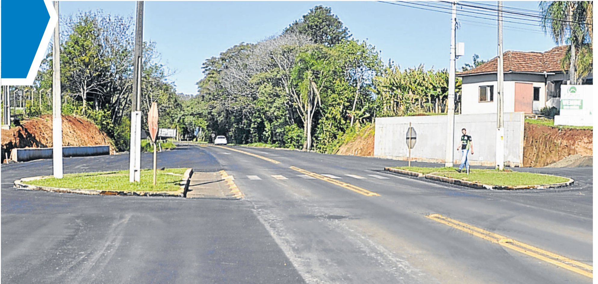
Rótula está sendo modificada para promover maior segurança
