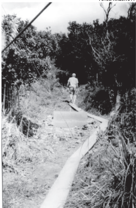
Construção e implantação da primeira planta transmissora na metade do Morro da Harmonia
