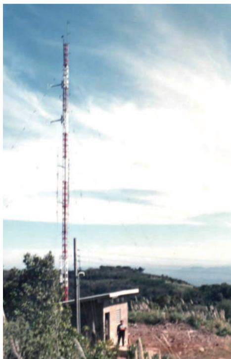
Primeira torre no alto do morro de Linha Harmonia concluída
