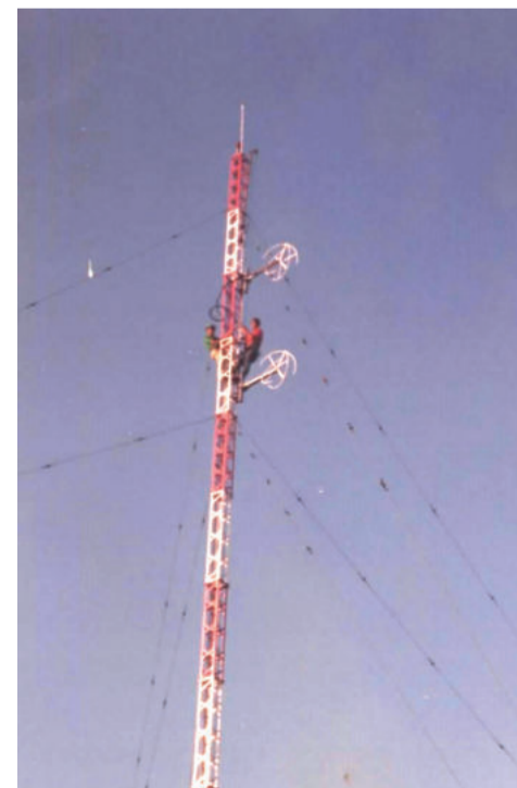
Construção e implantação da atual torre
