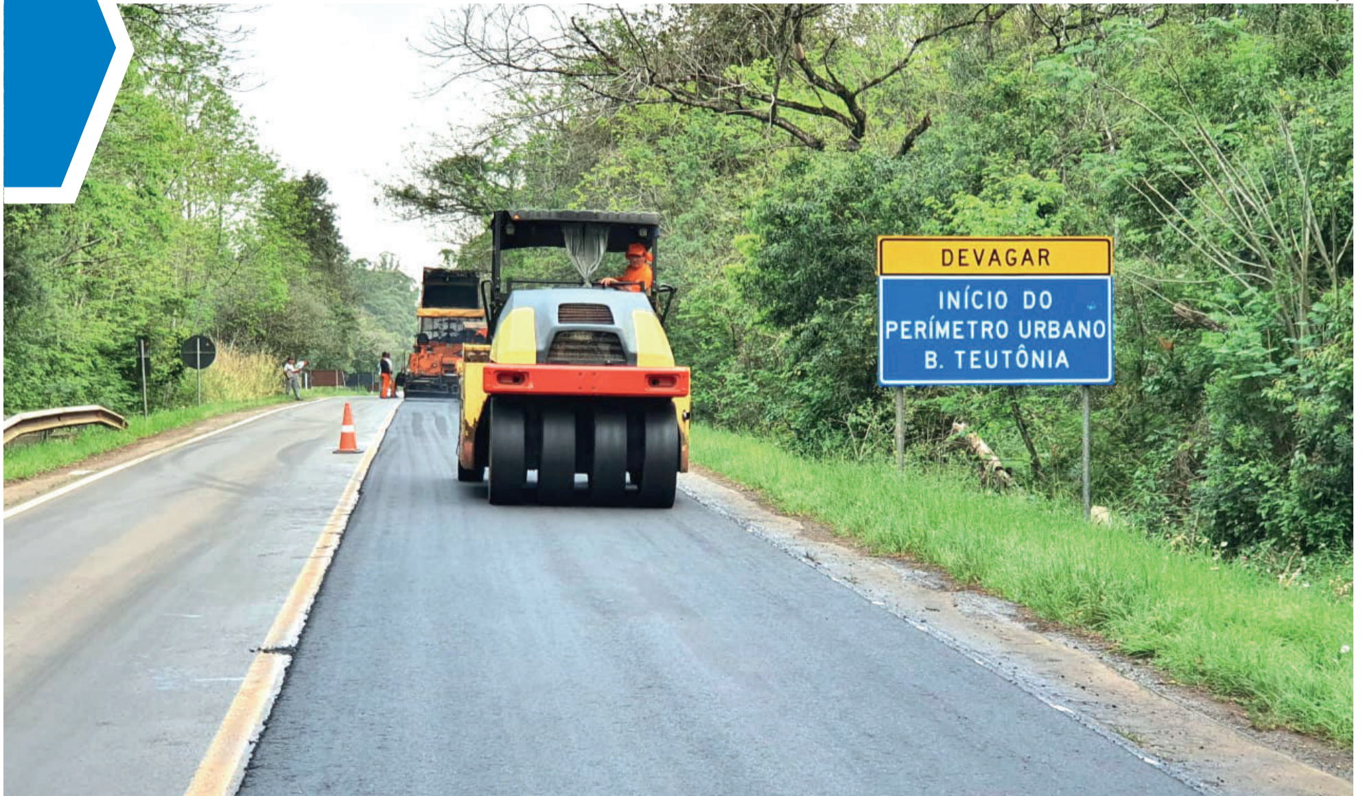
Obras devem garantir vida útil da ERS-128
