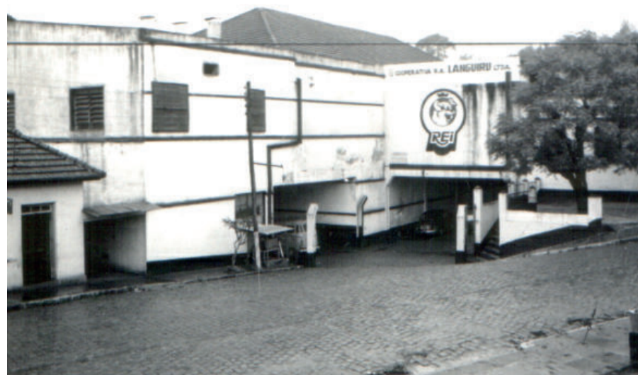
Antigo Frigorífico de Suínos da Languiru em Bom Retiro do Sul, foto da década de 1970
