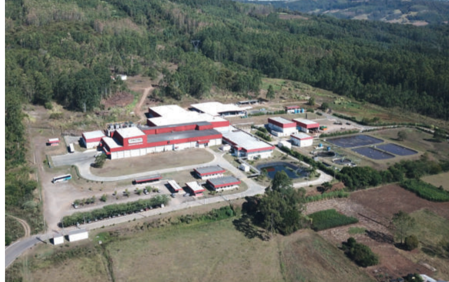
Frigorífico de Suínos, em Poço das Antas
