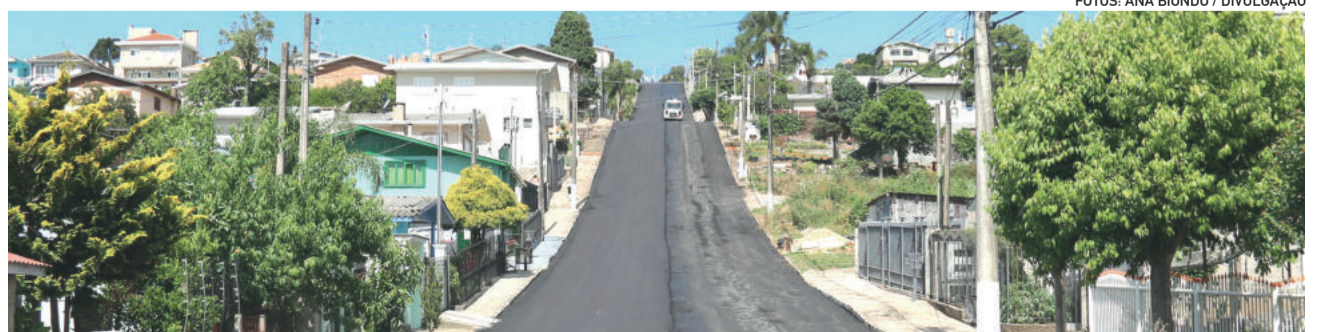
Pavimentação Rua Independência
