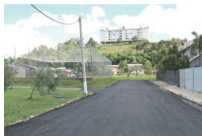
Pavimentação Rua Frei Miguel
