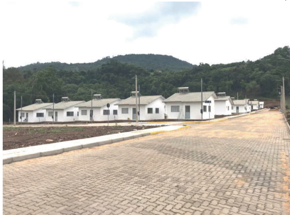
Obras foram finalizadas nos últimos dias
