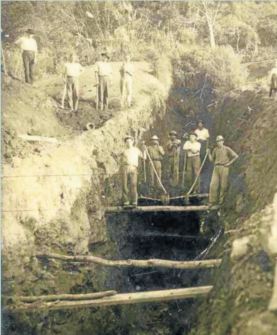
Agricultores usaram pás e picaretas para construir a barragem da Lagoa da Harmonia, primeira fonte de geração de energia da Certel
