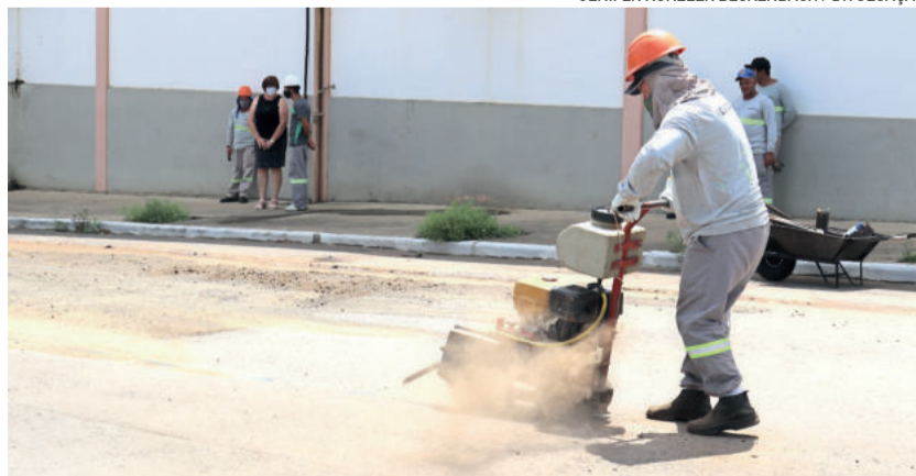
Obras iniciaram na segunda-feira e vão abranger diversos locais
