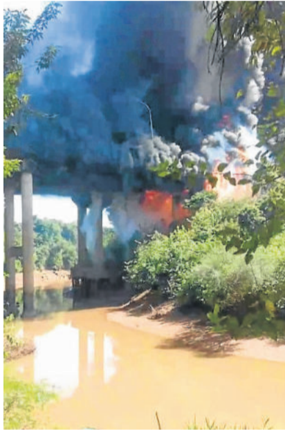
Acidente seguido de explosão e incêndio gerou danos na ponte sobre o Arroio Boa Vista
