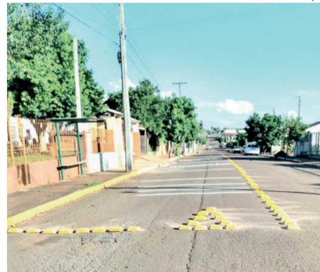
Novo modelo de redutor de velocidade é testado em Teutônia
