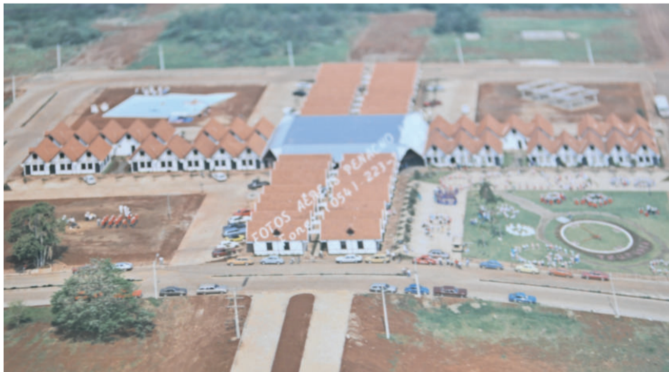
Construção do Centro Administrativo em 1985
