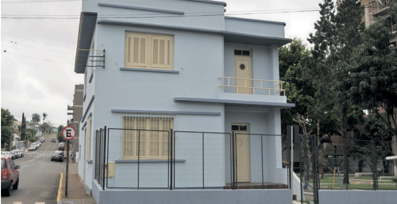
O prédio do Bairro Languiru é o mais preservado por fora, mas por dentro está condenado e não pode ser utilizado
