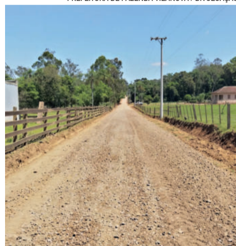
Serviço de limpeza e recuperação foram executados na localidade
