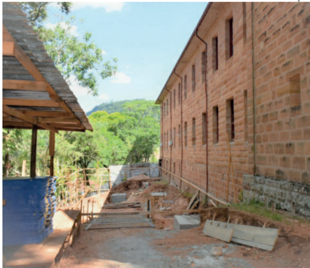
Obras seguem a todo vapor
