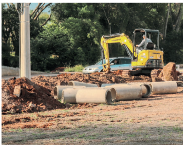
Obras iniciaram nesta semana em Teutônia
