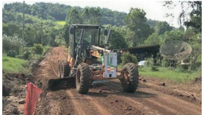
A equipe coordenada por Adriano Parolin atua na execução de serviços de terraplanagem em diferentes vias públicas de Arroio do Meio
