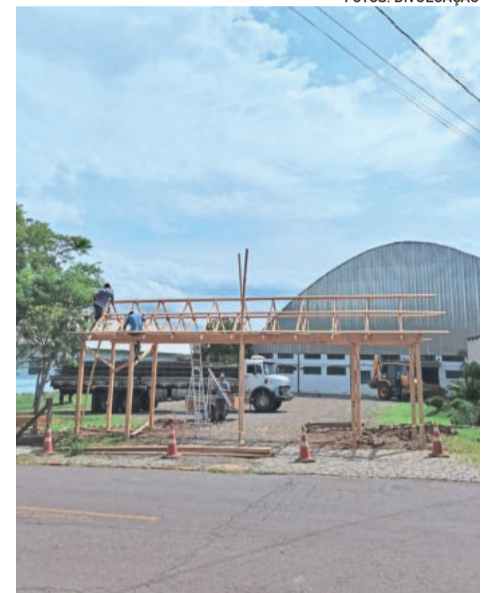
Estrutura está sendo montada junto ao parque que abriga o Ginásio Municipal e o Centro Comunitário Evangélico
