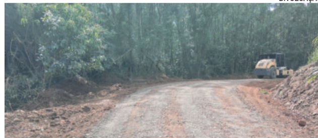
Estrada foi alargada e teve inclinação modificada
