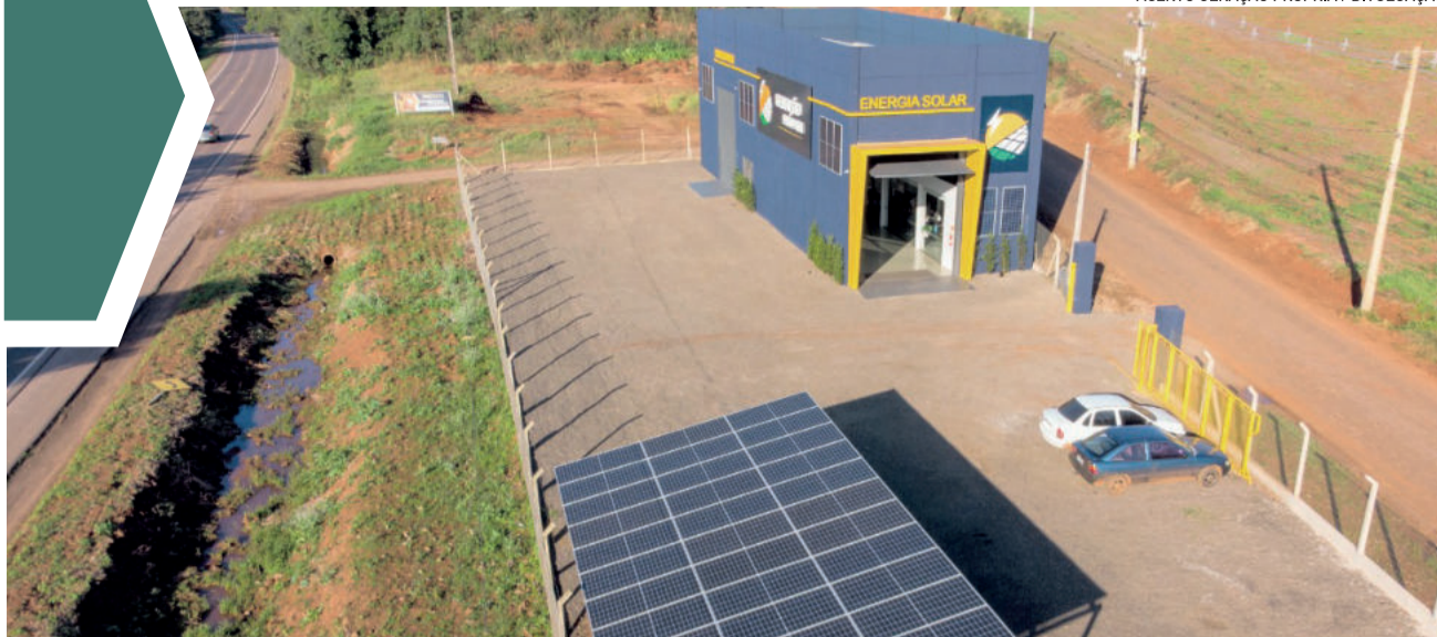
Car Port fica junto ao estacionamento coberto com placas fotovoltaicas
