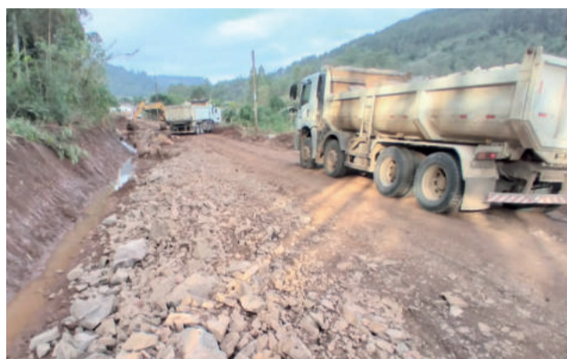
Em Santa Inês, está sendo pavimentada a Estrada Geral
