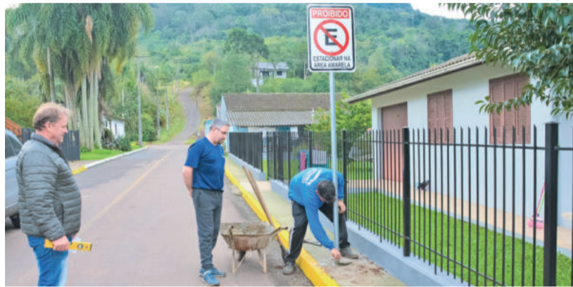
Placas já foram instaladas
