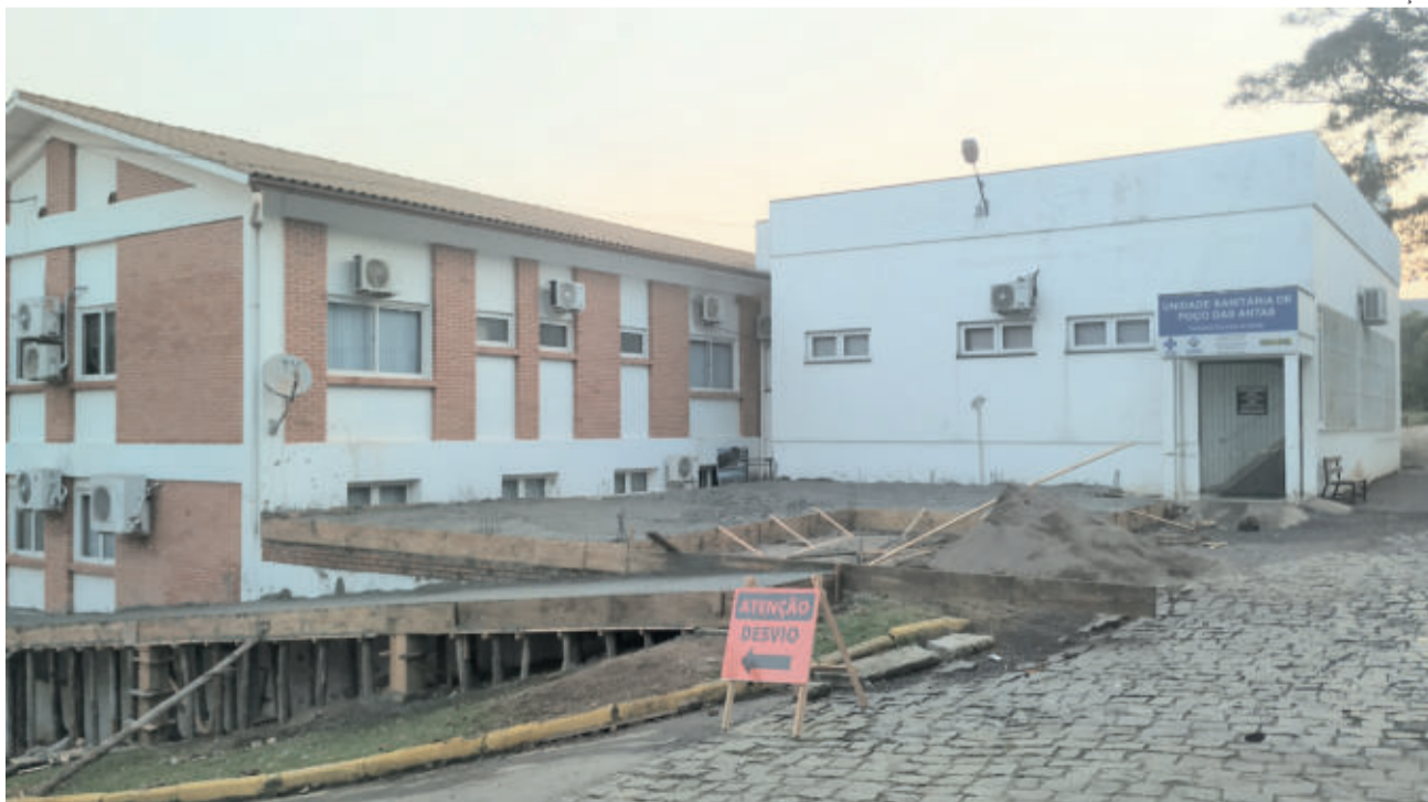
Obras iniciaram na parte externa do prédio
