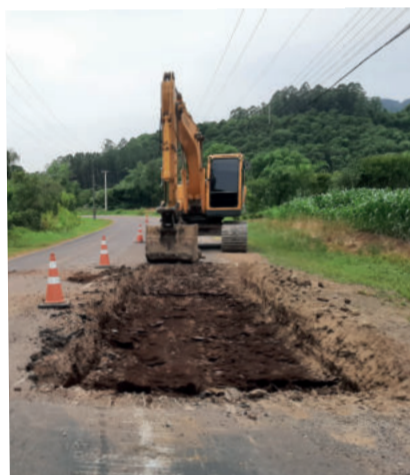
No momento, obras se concentram na Estrada da Seca Baixa
