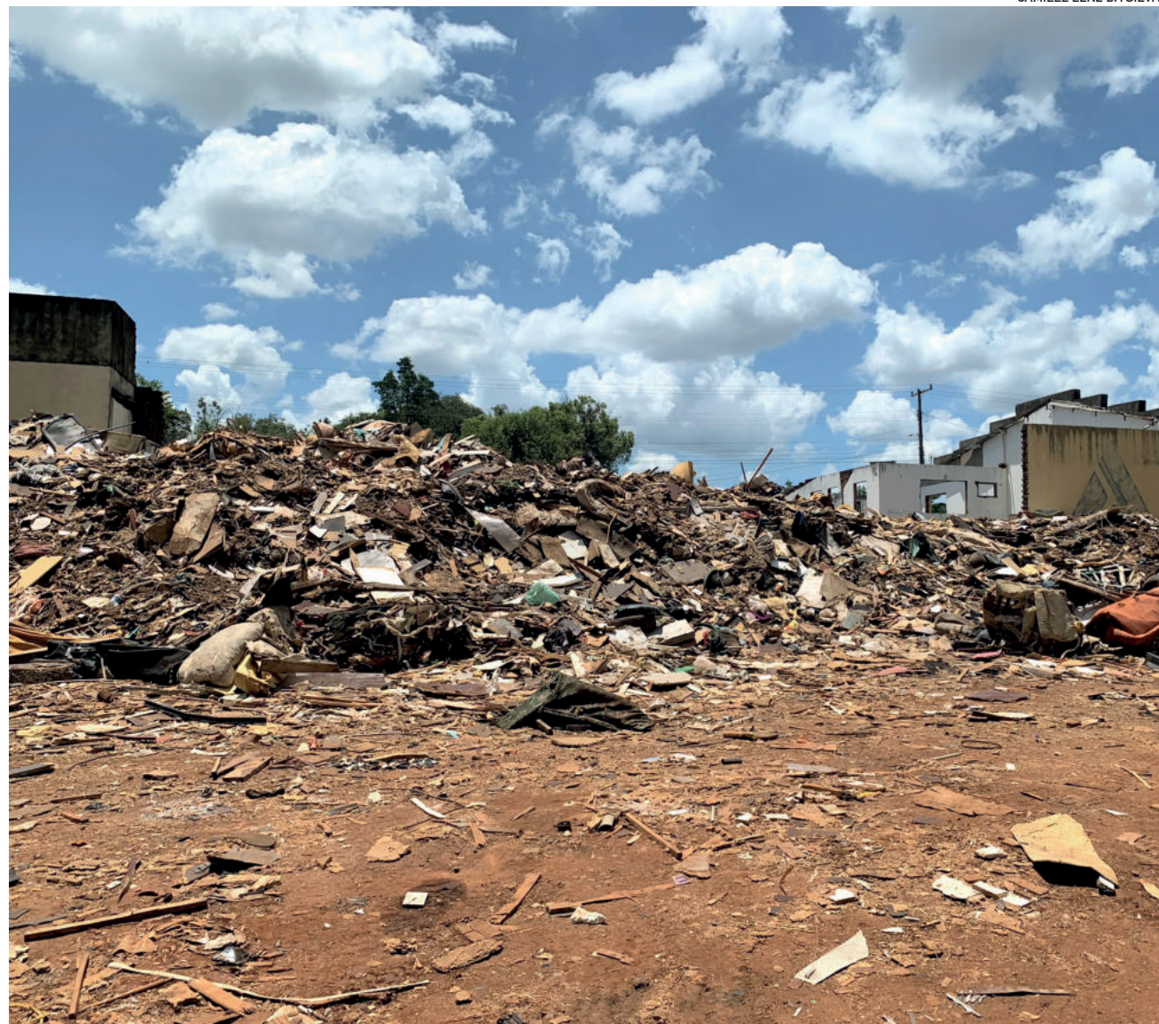
Depósito no Centro Administrativo é aberto, o que permite criação de pragas
