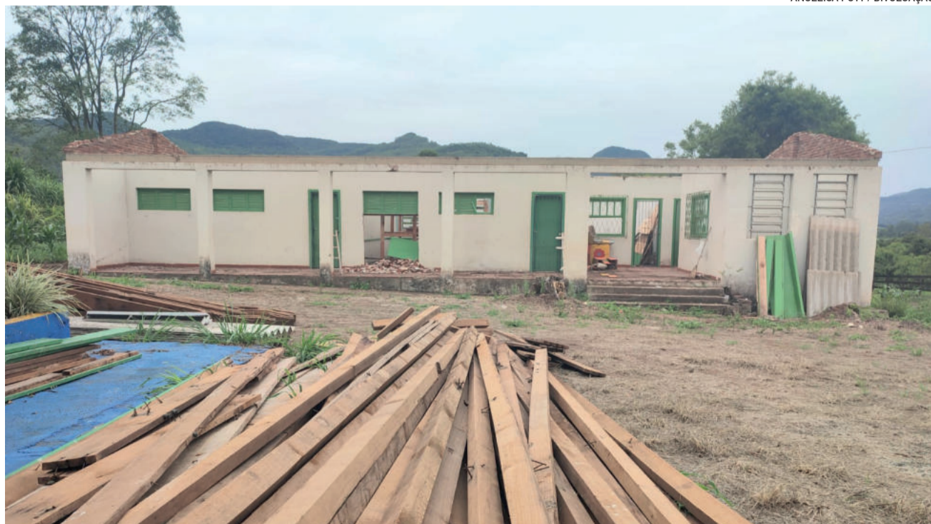
Prédio de antiga escola está sendo reformado para receber o projeto
