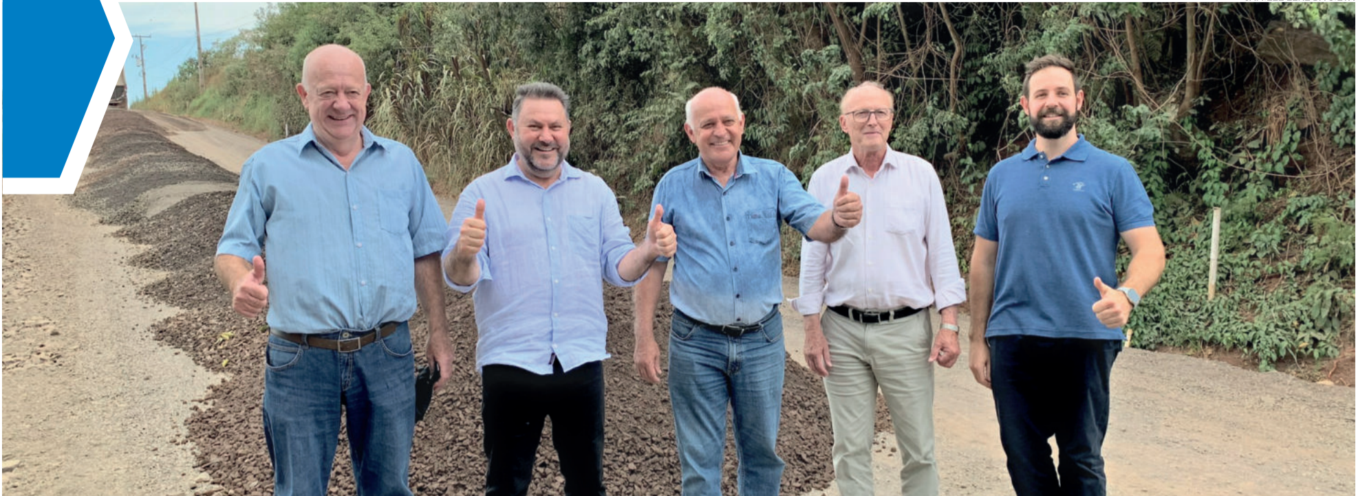
Dentre as obras, o asfaltamento de estrada da Linha Wink, em parceria com Teutônia. Obra foi visitada pelos prefeitos nesta semana
