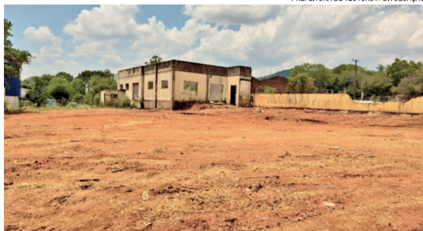
Terreno no Centro Administrativo teve limpeza concluída nesta semana
