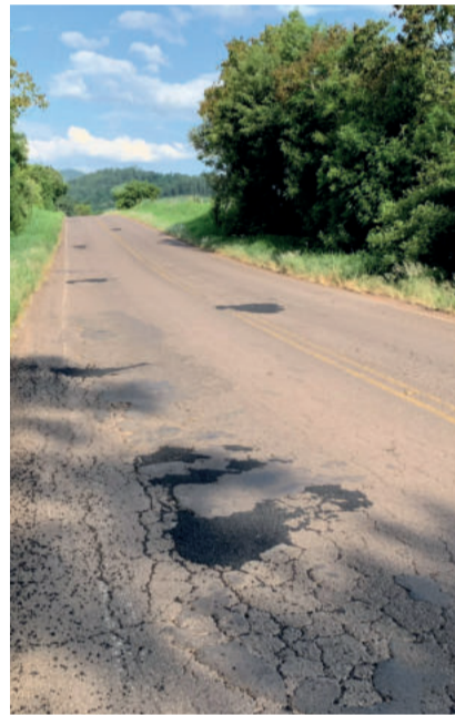
Operação foi realizada ao longo da rodovia
