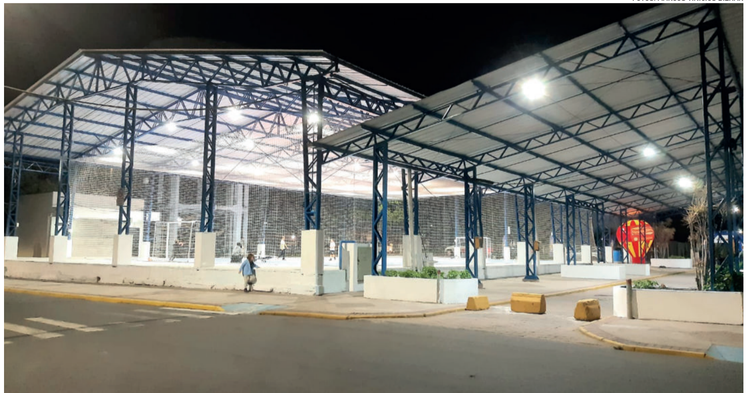
Estrutura metálica da quadra recebeu nova pintura
