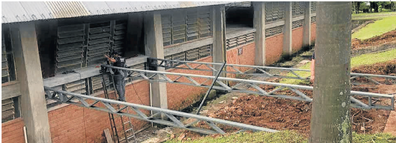
Iniciou nesta semana a instalação das passarelas
