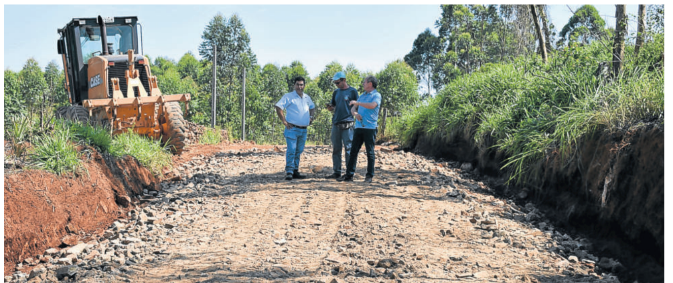
A estrada vicinal da localidade de Samambaia recebeu melhorias com nova drenagem e material compactado
