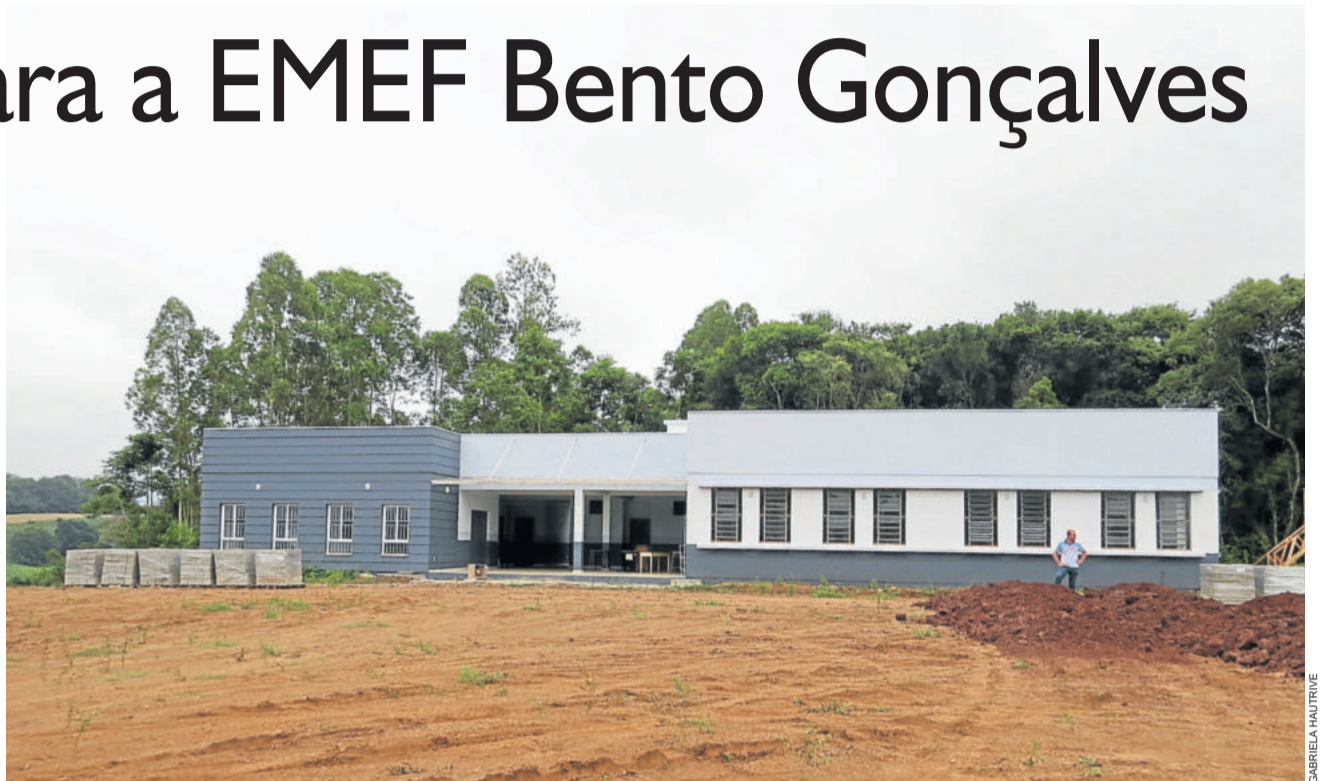
Secretaria de Obras vai concluir acessos e alunos já poderão ocupar o espaço no dia 19 de fevereiro
