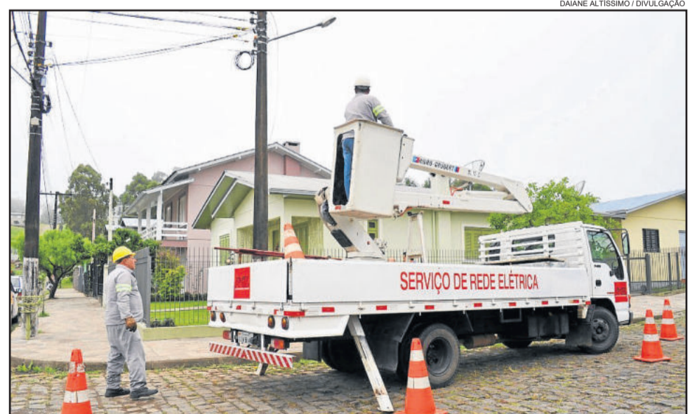
Equipe da empresa contratada realizam os serviços de manutenção
