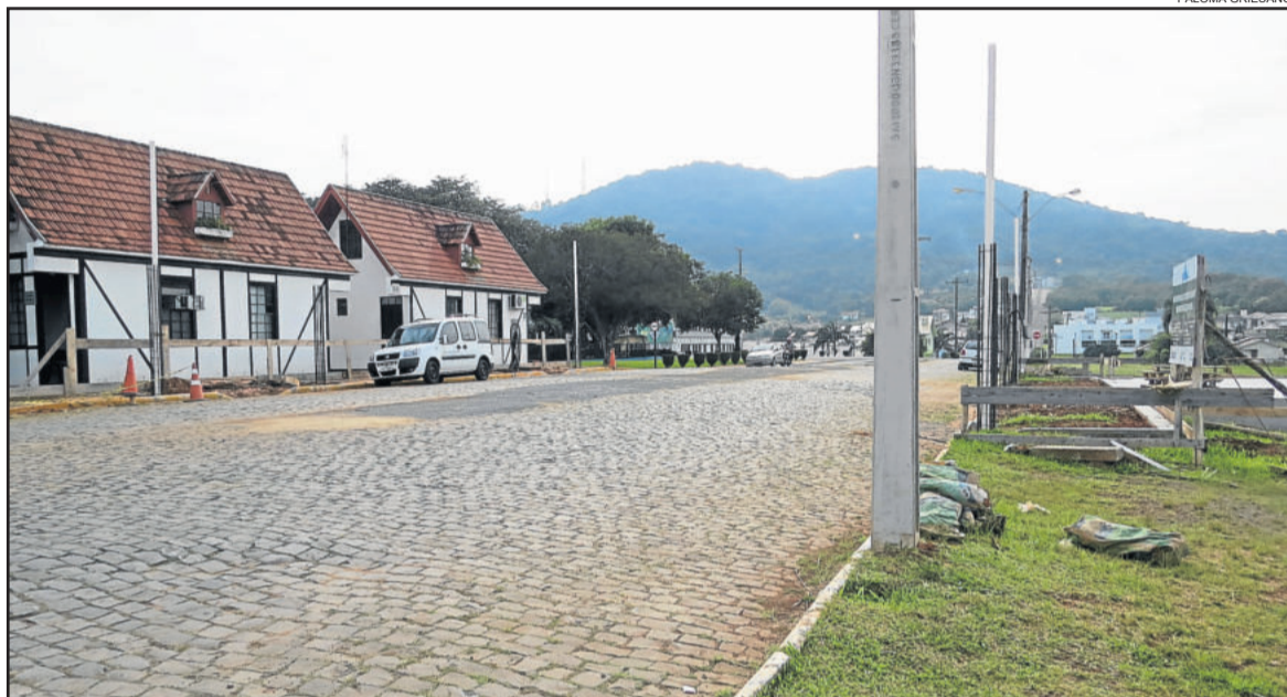
Rua coberta, instalada na Avenida 1 Sul, terá 20 metros de extensão
