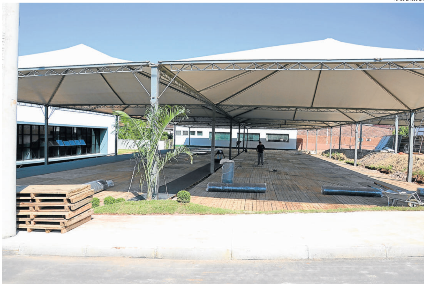
Estruturas estão sendo montadas
