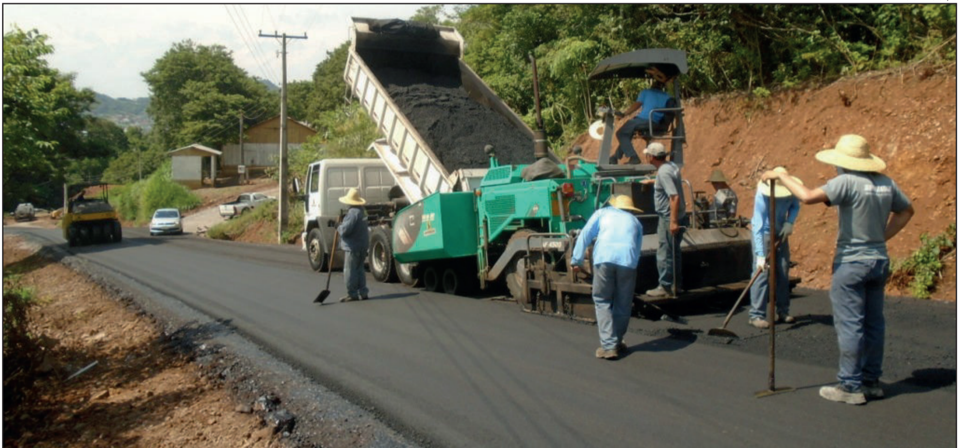
Para a conclusão da etapa 1, ainda restam a concretagem da sarjeta e a sinalização
