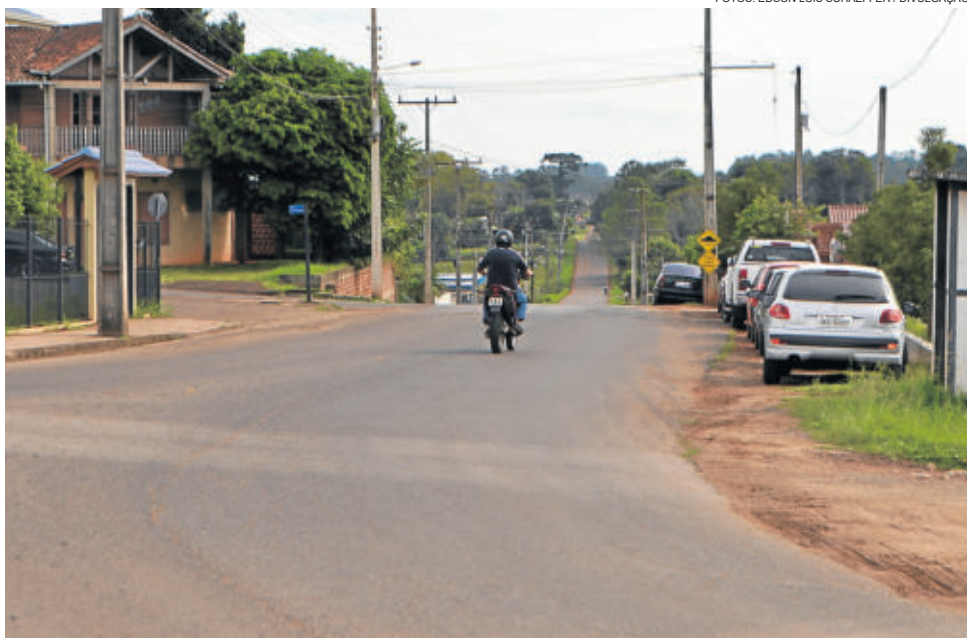
Rua 17 de Junho, em direção à Linha Ribeiro, receberá calçada no lado direito da via
