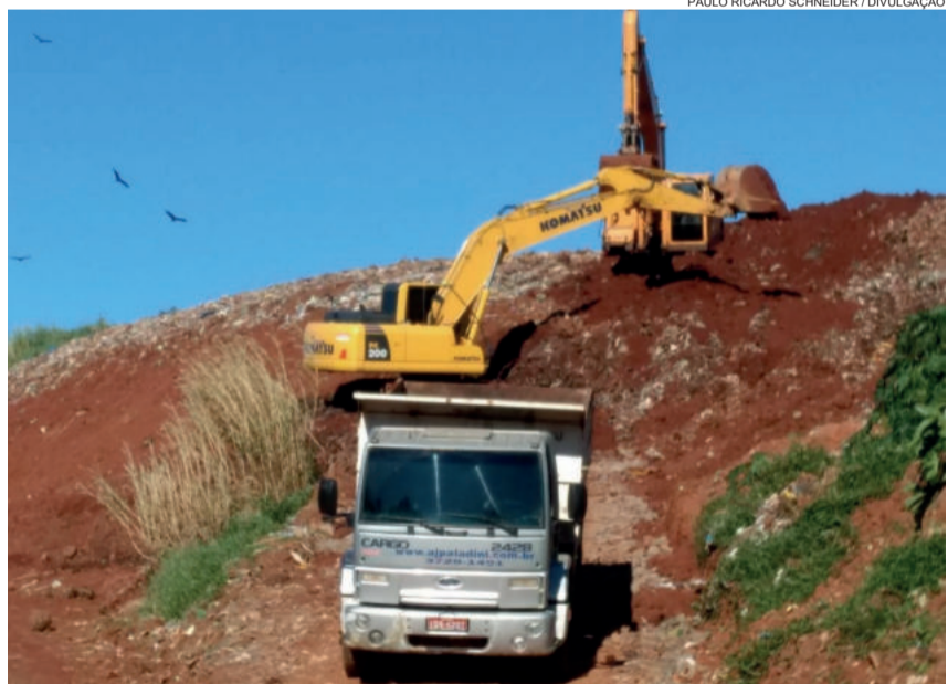
Máquinas e caminhões trabalham na cobertura da célula antiga
