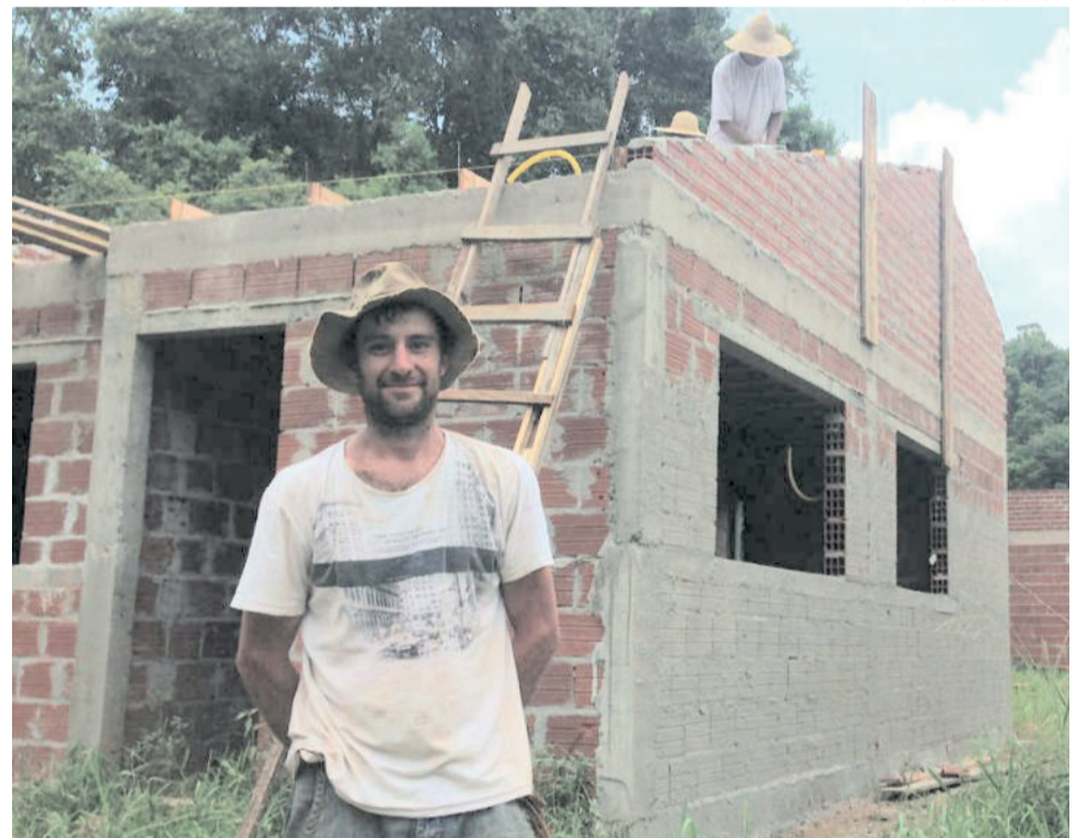
Gilmar Sell trabalha na obra do loteamento em que deve morar, com sua esposa e quatro filhos, a partir de 2020
