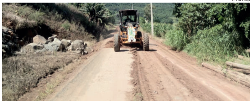
Estradas estão recebendo ensaibramento e nivelamento
