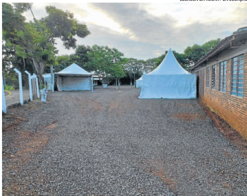
A montagem da infraestrutura está na parte final
