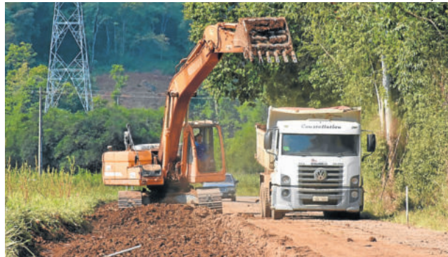
Máquinas trabalhando para asfaltamento no interior
