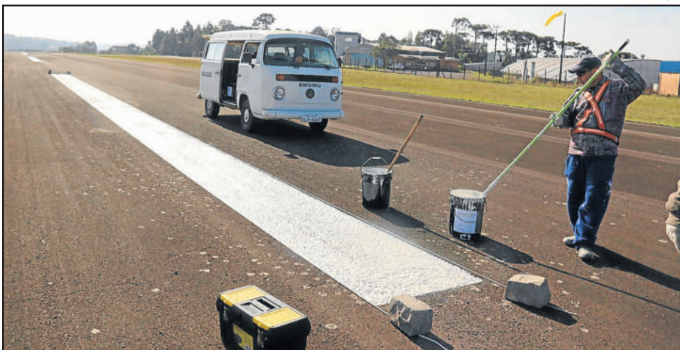
Foram utilizados 50 baldes de 18 litros de tinta para fazer as marcações
