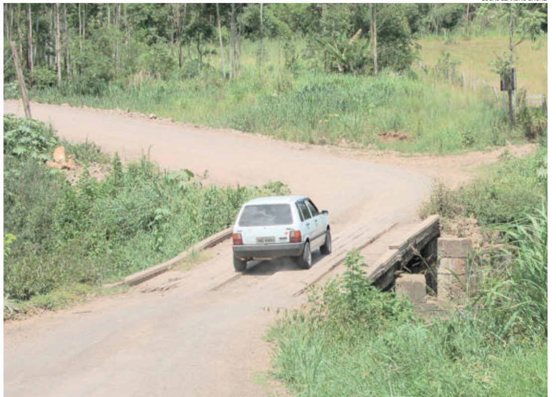
Ponte interliga o Bairro Boa Vista (Teutônia) e a localidade de Linha Frank (Westfália)
