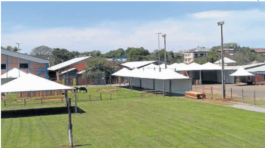
Lonas e estandes estão sendo montados
