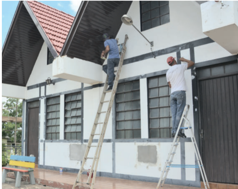
Obra está sendo executada pela Construtora Edil Ltda
