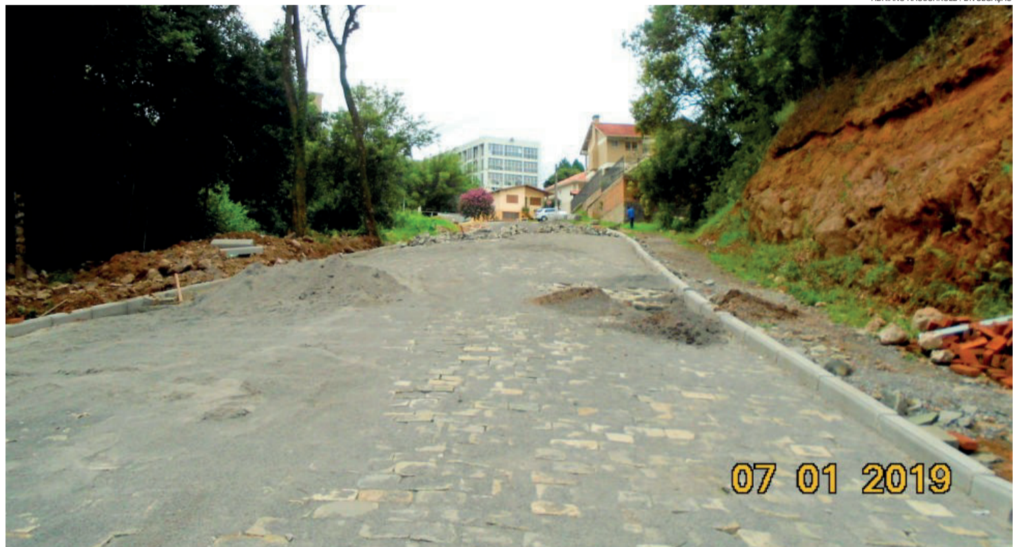
Pavimentação é realizada com pedra de basalto ou paralelepípedo
